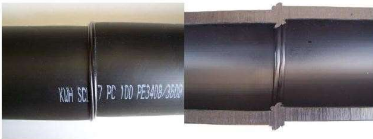
(c) Ống bảo mật chưa hoàn chỉnh hoặc gia nhiệt không đủ thời gian
